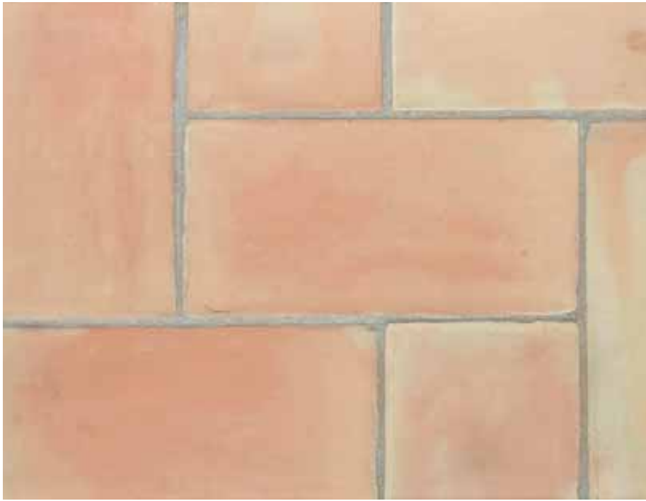
Pavimento posato con lato liscio a vista
