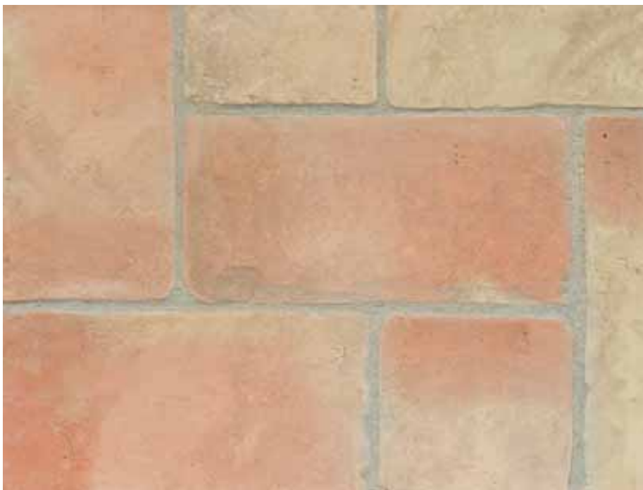
Pavimento posato con lato sabbiato a vista
